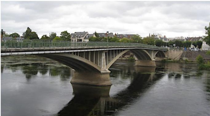
Mitte des Jahres 1899 begannen die Arbeiten an den Fundamenten, die Pfeiler und der Überbau als Betonage auf einem Lehrgerüst konnten noch bis Ende des Jahres im Rohbau fertiggestellt werden. Im März 1990 wurden Belastungstests mittels marschierenden Soldaten erfolgreich durchgeführt. Alle Betonarbeiten und die Ausstattungen waren im November 1990 abgeschlossen, sodass die feierliche Eröffnung im Dezember stattfand und die Brücke in 1,5 Jahren fertiggestellt wurde.
