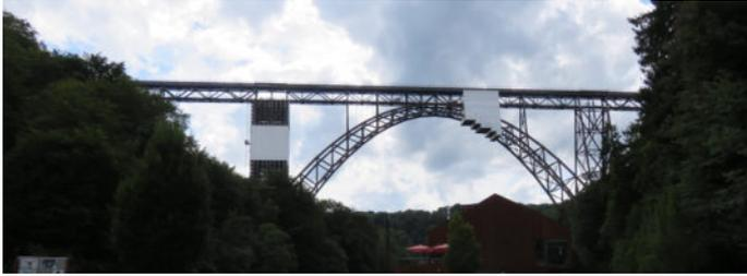
Die Müngstener Brücke ist die höchste Eisenbahnbrücke Deutschlands. Es handelt sich dabei um eine Fachwerkbogenbrücke mit aufgeständerter Fahrbahn als genietete Stahlkonstruktion. Durch den Bau der Brücke konnte der Schienenweg zwischen Solingen und Remscheid von 44 km auf 8 km verkürzt werden. Die Brücke wurde 1897 eröffnet und besitzt eine Gesamtlänge von 465 m, eine Höhe von 107 m und eine Hauptstützweite von 170 m.
