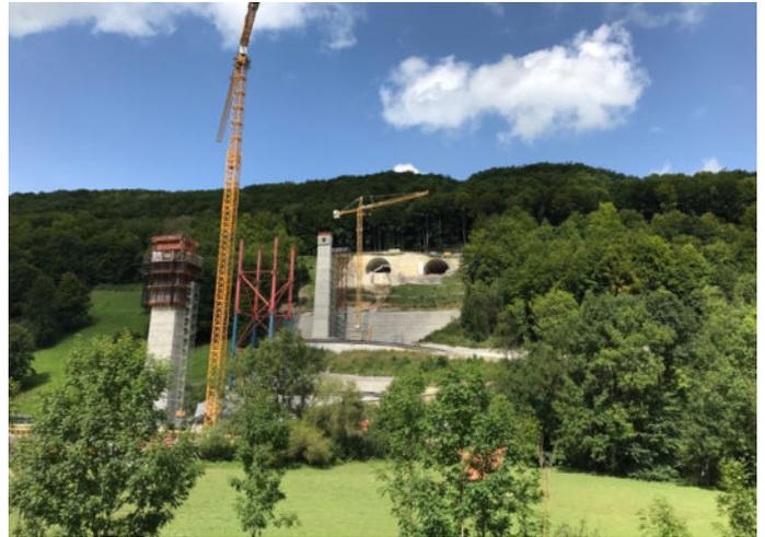
Die Länge der Filstalbrücke wird in etwa 485 m betragen und führt die Eisenbahnstrecke über das Filstal. Mit einer Höhe von ca. 85 m wird die Filstalbrücke die dritthöchste Eisenbahnbrücke Deutschlands, nach der Müngstener Brücke und der Rombachtalbrücke.
