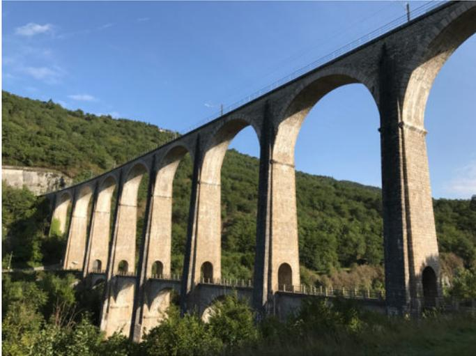
Das Cize-Bolozon-Viadukt wurde als doppelstöckige Bogenbrücke konzipiert und überführt die Bahnlinie Haut-Bugey sowie eine Straße dem Ain. Das 273 m lange, gemauerte Bauwerk erreicht bei einer maximalen Pfeilerhöhe von 73m Spannweiten bis 16 m.
