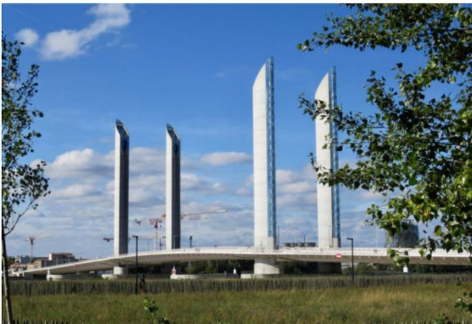
Die Besonderheit dieser Brücke liegt darin, dass sie einen beweglichen Brückenarm besitzt, der bei Bedarf angehoben werden kann und somit größeren Schiffen die Durchfahrt unter der Brücke ermöglicht. Sie gehört zu den sogenannten beweglichen Brücken.
