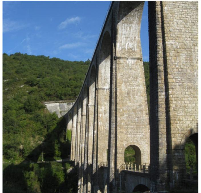
Die Rekonstruktion ist mit einigen Ausnahmen identisch zu dem ursprünglichen Bauwerk errichtet worden, nur dass die Steine weitestgehend durch Beton ersetzt und die Straße von 1,9m auf 3m verbreitert wurde.
