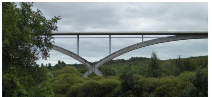
Das Besondere an dieser Brücke ist, dass das Tragwerk aus zwei Halbbögen besteht, welche sich auf einer Höhe von 15 m kreuzen und dessen Fundamente 25 m auseinander liegen.
