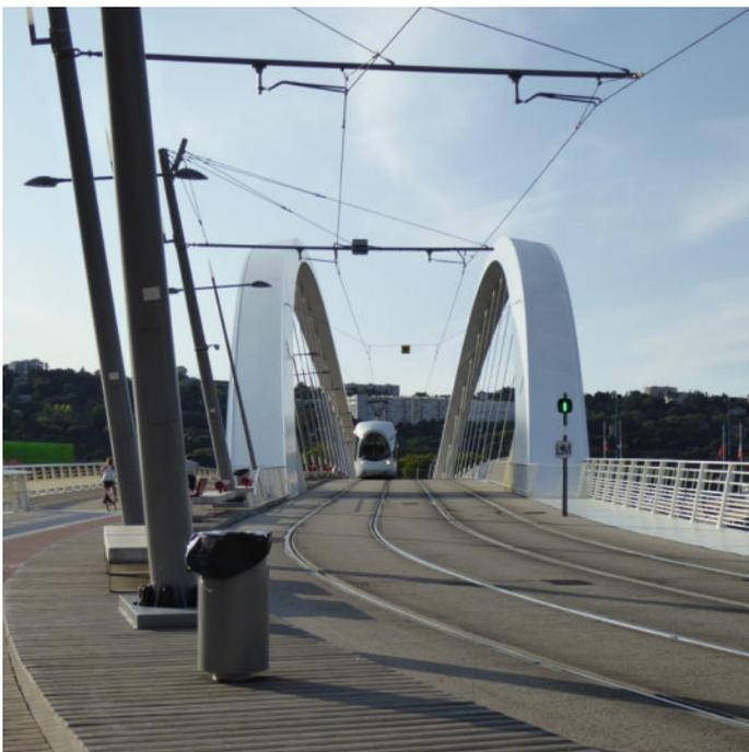
Die schlanke Ausführung ist durch hochfesten schweißbaren Feinkornstahl möglich, der eine hohe Streckgrenze und durch sein feines Korn eine hohe Duktilität aufweist. 2014 wurde die Brücke mit dem LoadSCAN™-System ausgestattet. Dabei wurden die Bolzen der Seilendbeschläge durch speziell präparierte LoadSCAN™-Bolzen ersetzt, die eine präzise und permanente Messung der im Seil herrschenden Normalkräfte ermöglicht.
