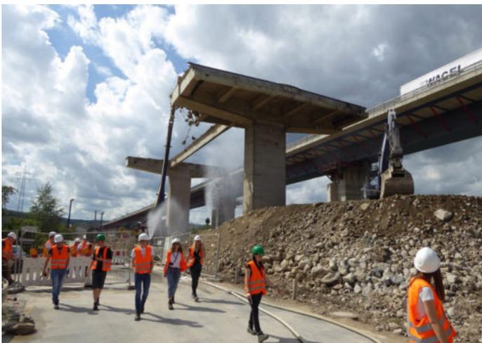
Der Ersatzneubau der **Lennetalbrücke** besitzt eine Länge von 979,5 m auf 14 Felder aufgeteilt und überführt die A45 über das Lennetal. Die Brücke befindet sich in einer Höhe zwischen 20 und 30 m über dem Gelände. Das Spannende an der Brücke ist, dass die erste Brücke längseingeschoben und nach Abriss der Bestandsbrücke quer in Endlage verschoben wird.
