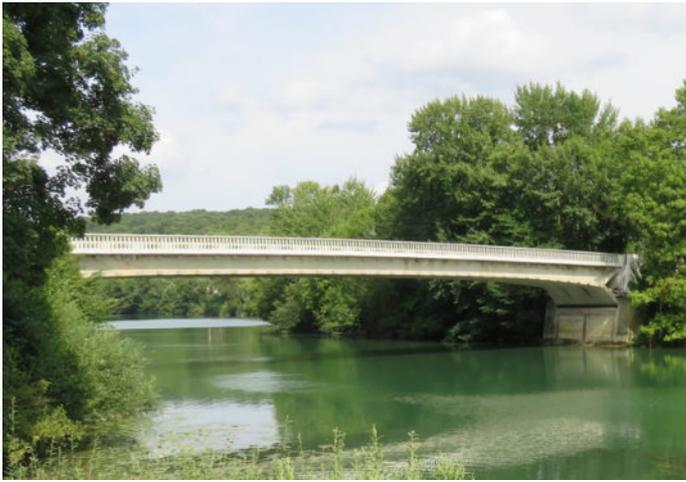
Die Pont du Luzancy ist eine zweispurige Straßenbrücke und überspannt die Marne mit einer Stützweite von 55 m und einer Gesamtlänge von 76 m.
